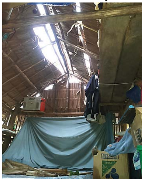
Pastorenhaus der PMA Amaga – das musste massiver wieder aufgebaut werden
